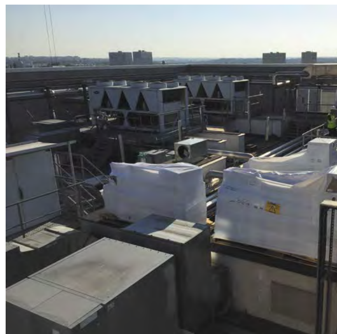
Installation des nouvelles centrales de traitement de l'air sur la toiture des Archives nationales, site de Pierrefitte-sur-Seine © Séverine Delamare
